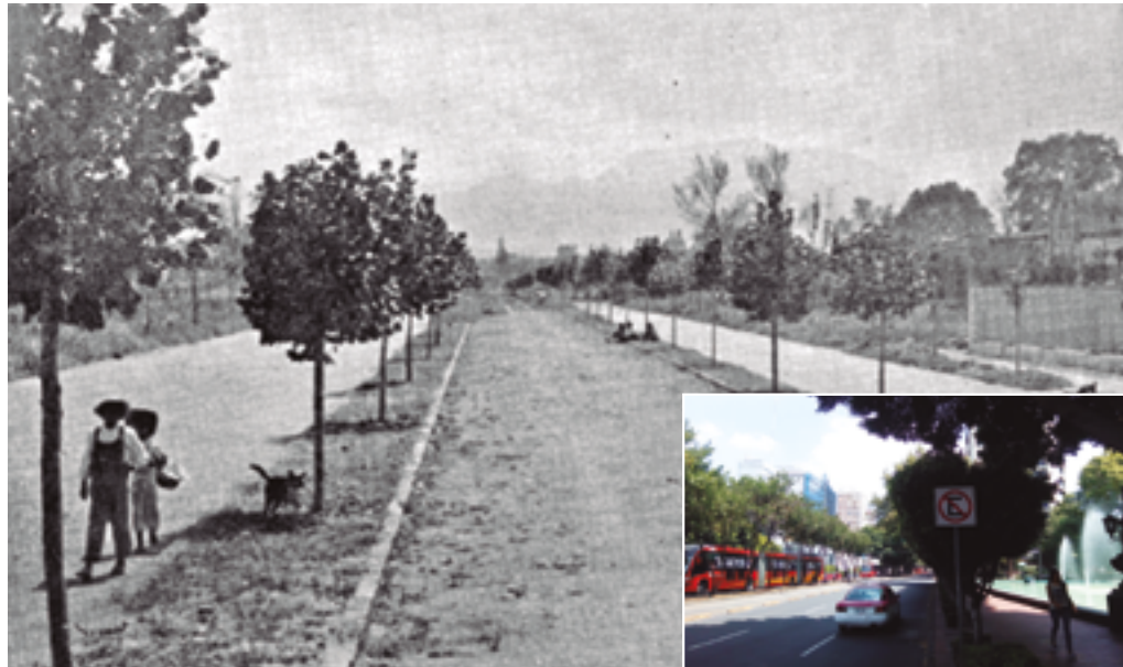
La actual avenida Insurgentes Sur, a la altura de Mixcoac, en los años treinta.
