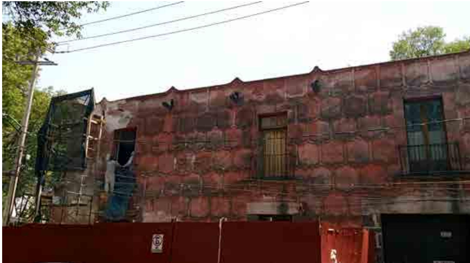
Casa de La Malinche en restauración.
