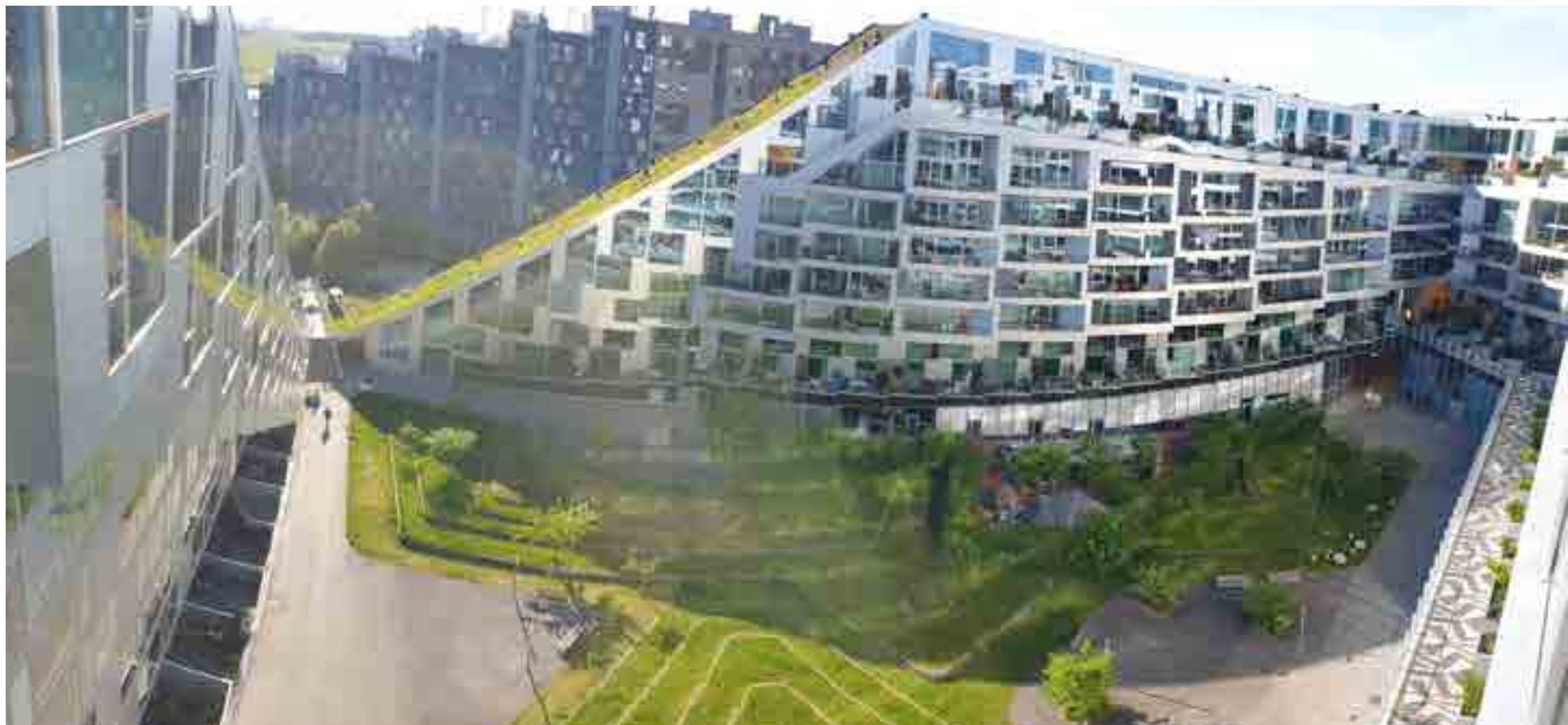
Edificio 8, en el sur de la ciudad. Cuenta con paredes y techos verdes. A los departamentos se puede llegar a través de un camino (en pendiente) usado para bicicletas o para hacer ejercicio.
