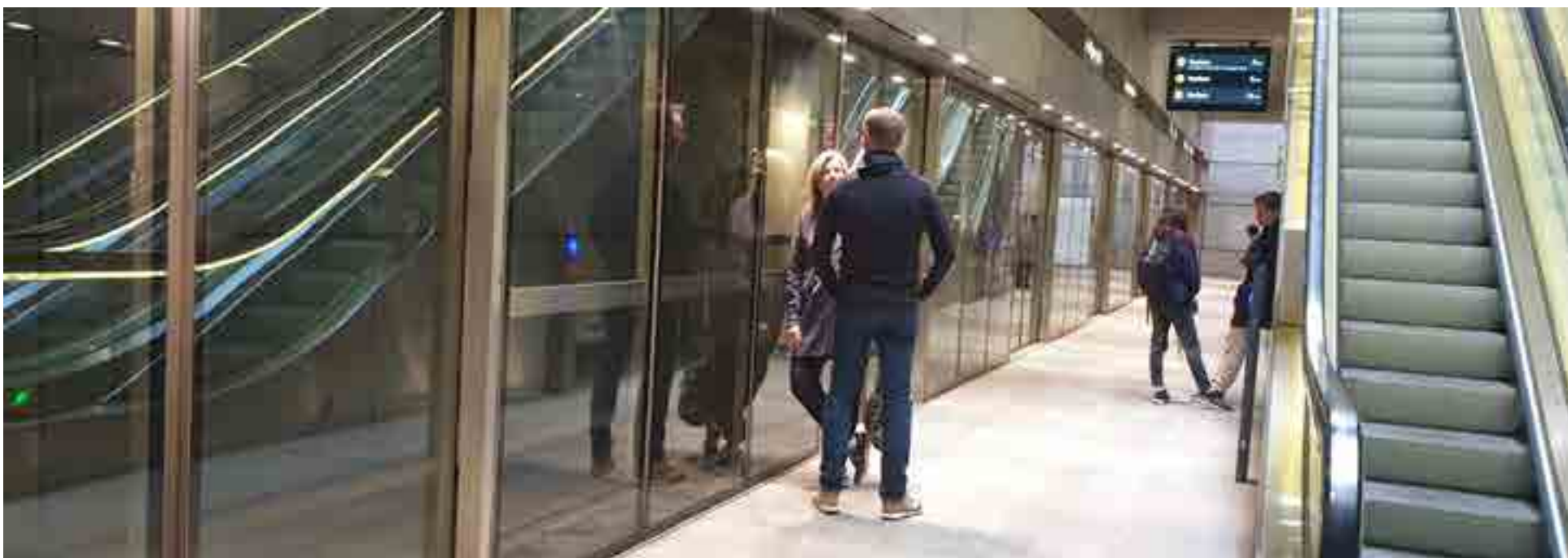
Estación de metro, con paredes de vidrio para evitar accidentes (solo se abren cuando llega el tren). Todos los trenes funcionan automáticamente, sin conductor.
