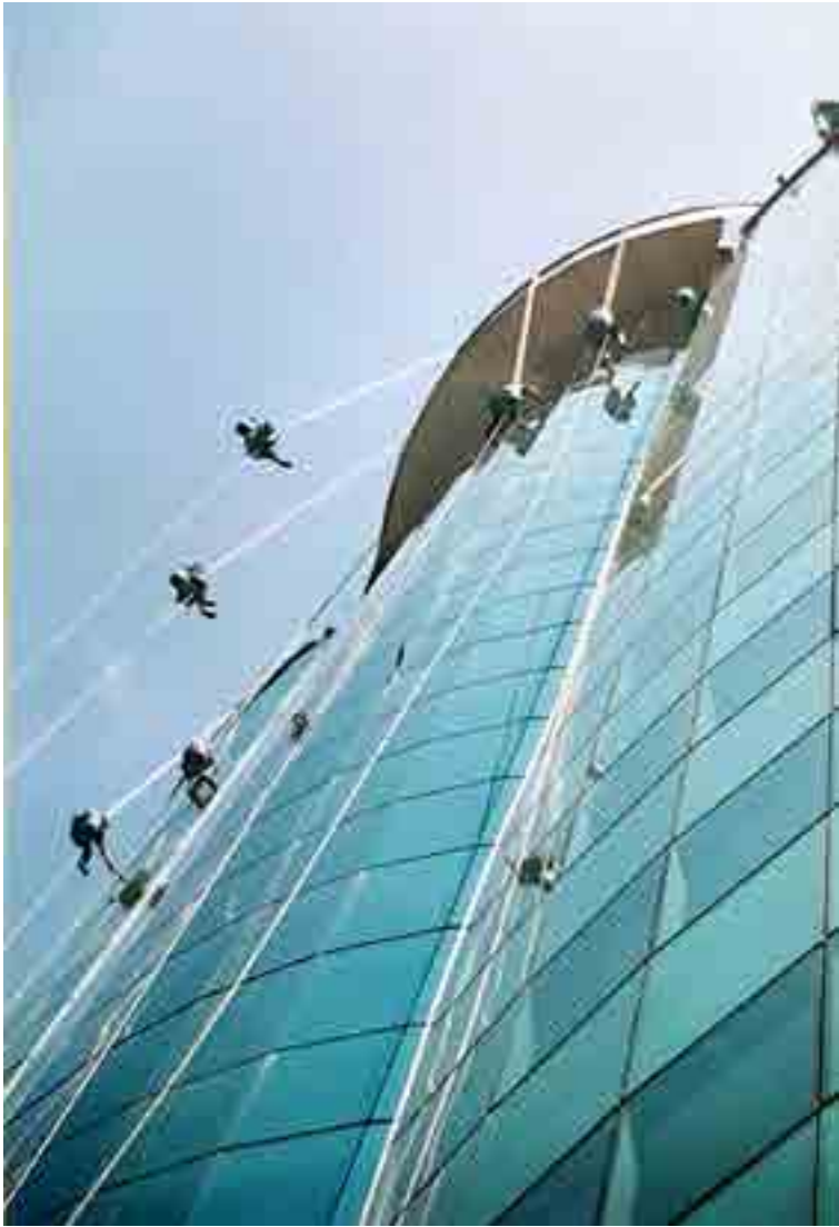
Limpieza en la Torre de los Dos Parques.
