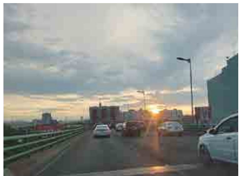
El segundo piso del Periférico
